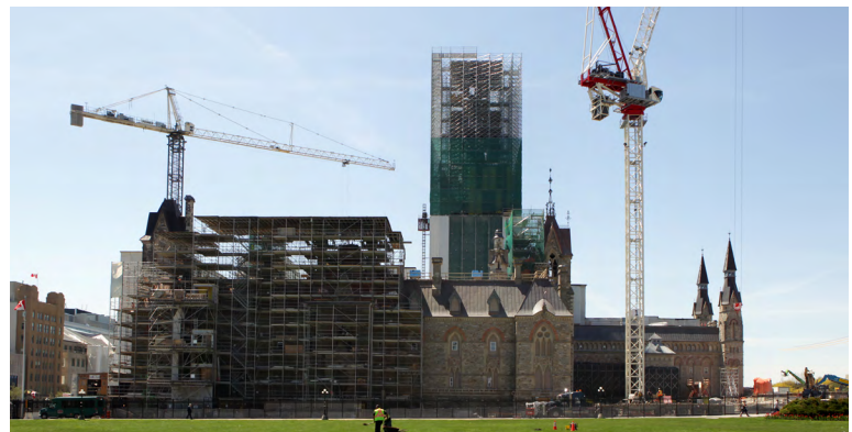
Restauration de l'édifice de l'Ouest
